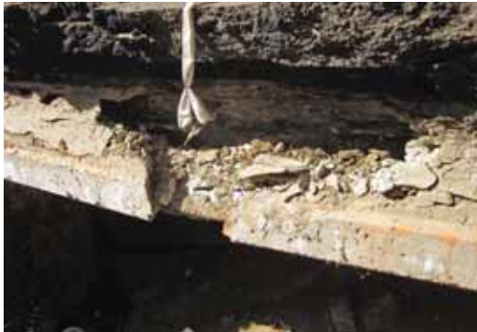
Тем временем под дебаркадером уже треснула балка
