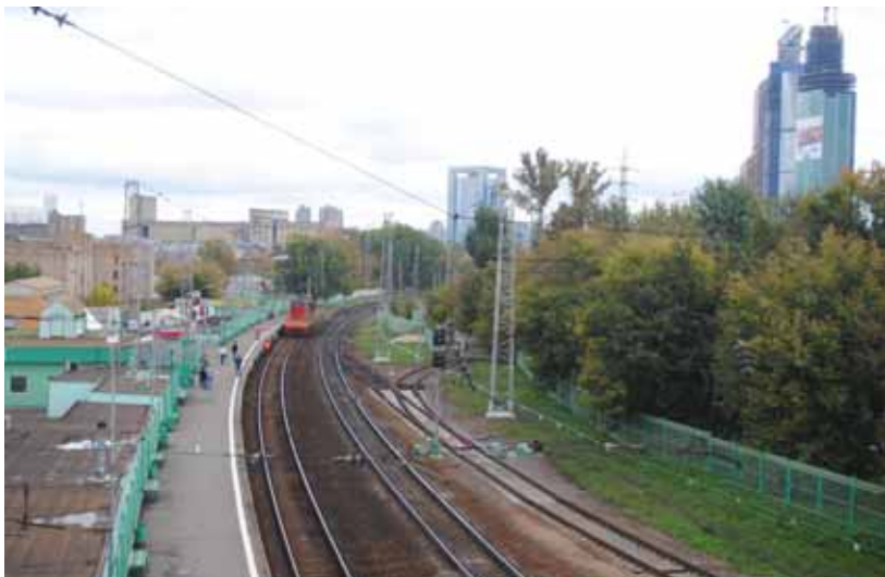
В идеале железные пути необходимо убирать за границы города, а вместо них проложить новые дороги
