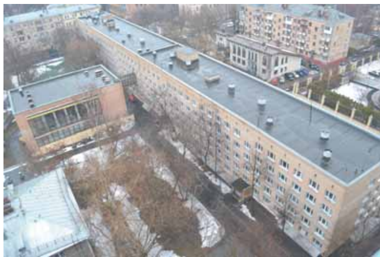
На месте этой 5-этажки планируется строительство трех 15-этажных башен
